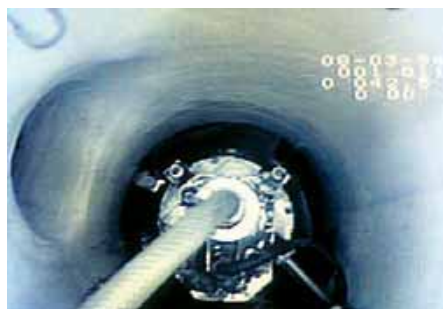
Abb. 4: Ergebnis Partliner mit integriertem Sidelineer [KMG]
