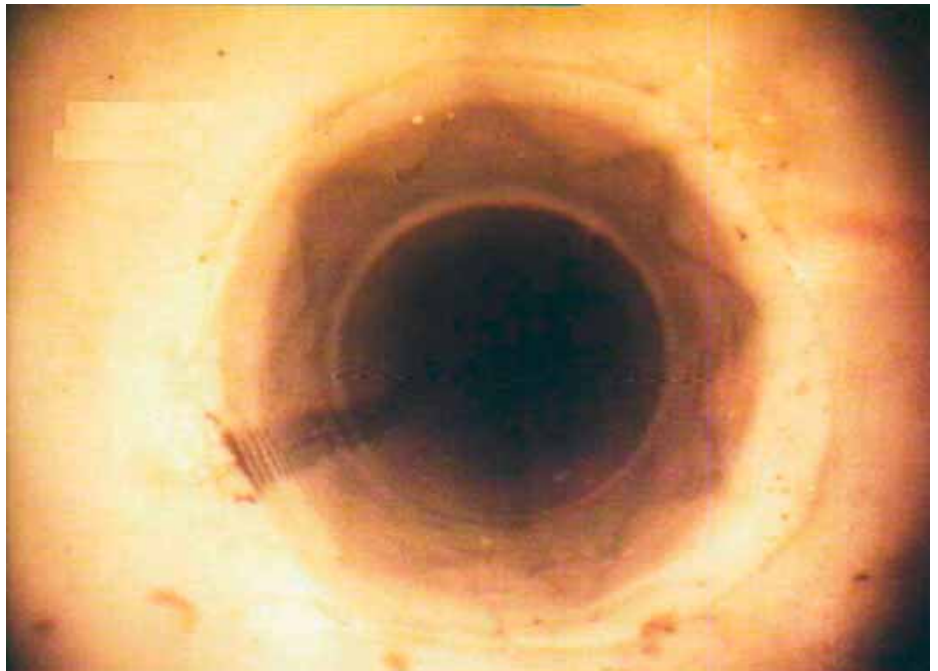
Abb. 6: Ergebnis FAS [Insituform Rohrsanierungstechniken]
