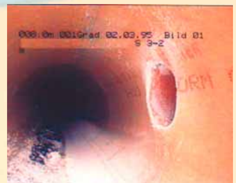
Abb. 2: Aufgefräster Anschluss ohne Einbindung (1995) [Insituform-Brochier]
