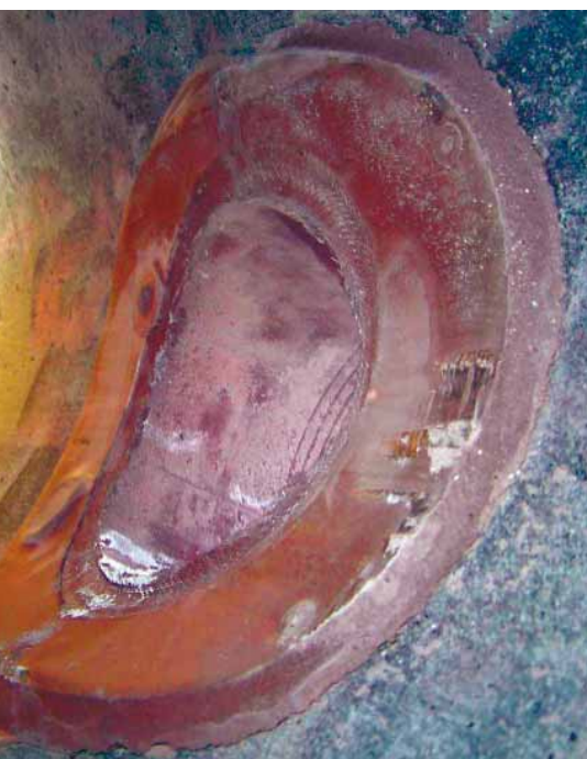
Abb. 10: EL-Stutzsanierung mit Epoxy-Mörtel
