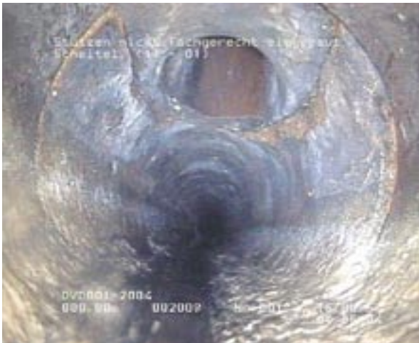
Auch der Aufstieg in solche Anschlüsse ist heute möglich. Foto: Grundstücksentwässerung ONLINE
